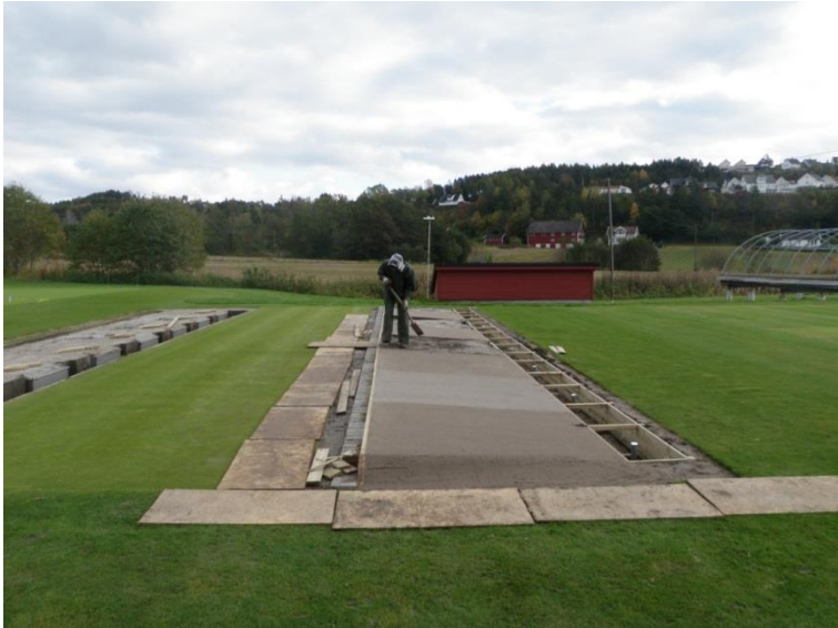
Bilde 5. Utlegging og komprimering av vekstmasse, okt. 2015. Vekstmasse med torv har lysere farge enn vekstmasse med kompost. Foto: Trygve S. Aamlid
