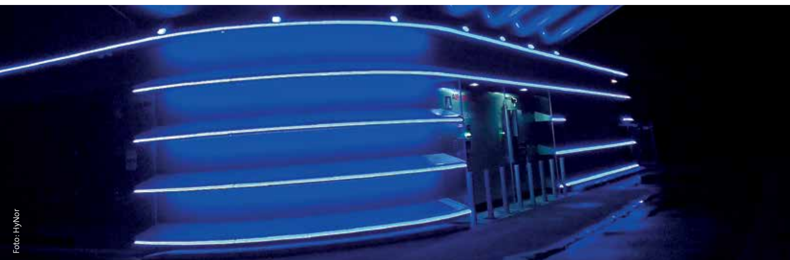
HyNor Oslo hydrogenstasjon.
