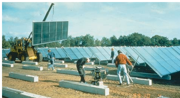
Montering av solfangerer i et stort solvarmeanlegg i Sverige.
