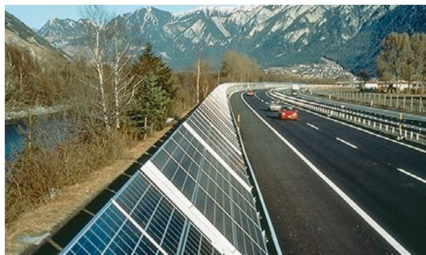
Solceller på støyskjermer langs motorvei i Sveits
