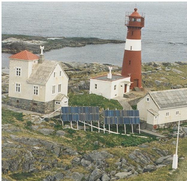
Grasøyane fyr nær Ålesund. Totalt 44 m 2 solceller, 80 paneler, leverer strøm til en batteribank med lagringskapasitet på 7000 Ah ved 24 V; 168 kWh. Kystverkets største installasjon.
