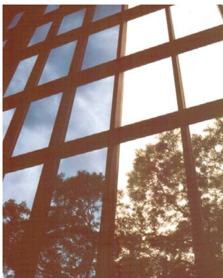
Dynamisk glassfasade der transmisjonen kan variere i 5 trinn med en regulator. Pris omlag 30% høyere enn tradisjonelt glass + solavskjerming (Kilde: Flaberg GmbH)
