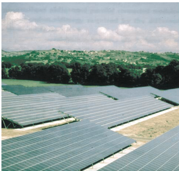
Solcelleanlegg i MW-klassen, Serre i Italia
