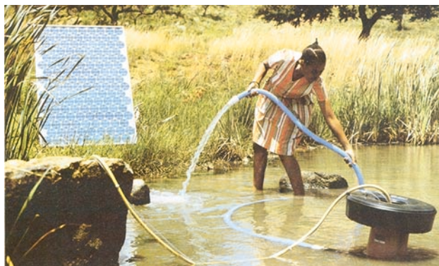
Vannpumping med solceller
