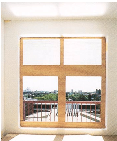
Holografisk vindu som reflekterer lys opp i taket for økt unyttelse av dagslys.
